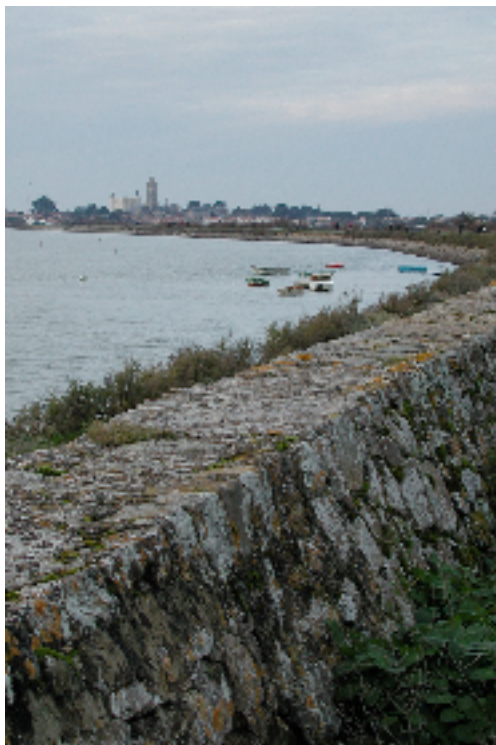
La chaussée Jacobsen vue de Fort Laron
